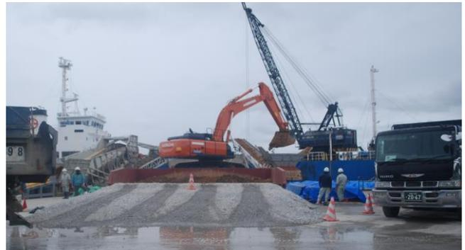
塩川港南側岸壁の運搬船1隻にベルトコンベヤー2台を設置し、赤土を積みこんでいました。北側岸壁では台船1隻に積み込んでいました。（5月31日、午前11時）
