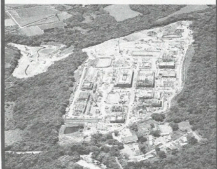
沖縄県石垣市で建設中の陸上自衛隊駐屯地＝8月
