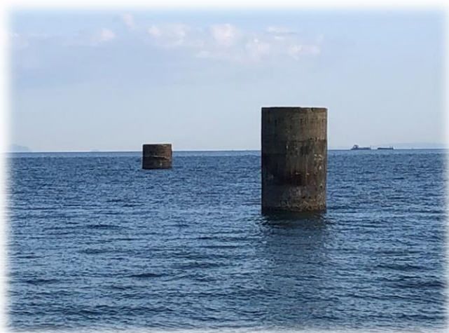
宇部市床波海岸の海から突き出ている 二本のピーヤ（排気・排水筒）
